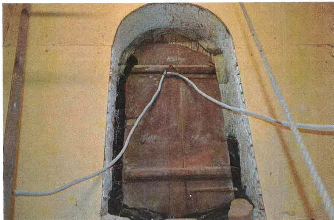
Il. 16 Chełmce, Kościół parafialny p.w. Św. Katarzyny – ściana południowa wieży, II kondygnacja - widok na otwór okienny, zamknięty okiennicą deskowo-szpungową, uszczelnioną workami
