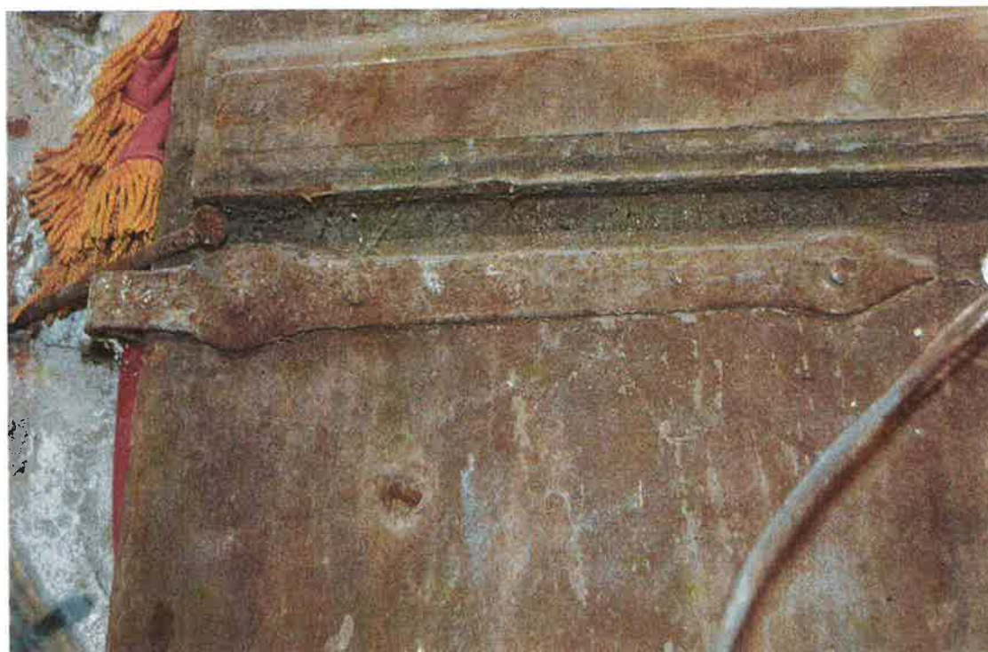
II. 20 Chełmce, Kościół parafialny p.w. Św. Katarzyny Aleksandryjskiej, wieża. okiennica - widok na pierwotny zawias pasowy hakowy, stalowy, zawieszający skrzydło okiennicy na węgarku
