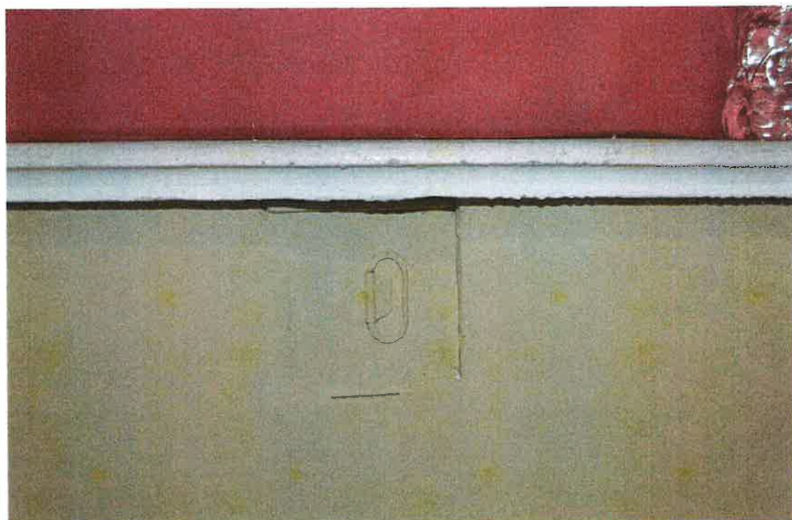
Il. 26 Chełmce, Kościół parafialny p.w. Św. Katarzyny – zakrystia, elewacja południowa - widok na fragment parapetu wewnętrznego stolarki okiennej oraz podparapetową szufladkę na wodę fot. Ewa Bożejewicz 2023 r.
