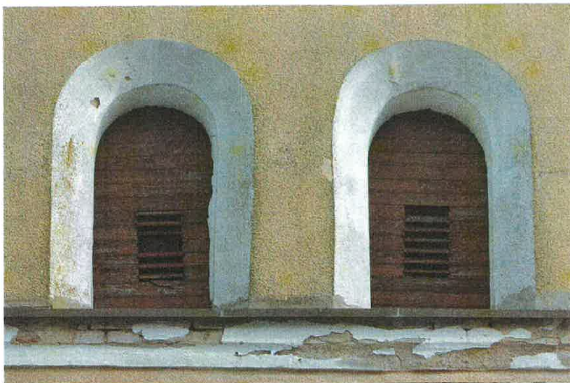
II. 7 Chełmce, Kościół parafialny p.w. Św. Katarzyny Aleksandryjskiej - elewacja zachodnia wieży – widok na okiennice w III kondygnacji
