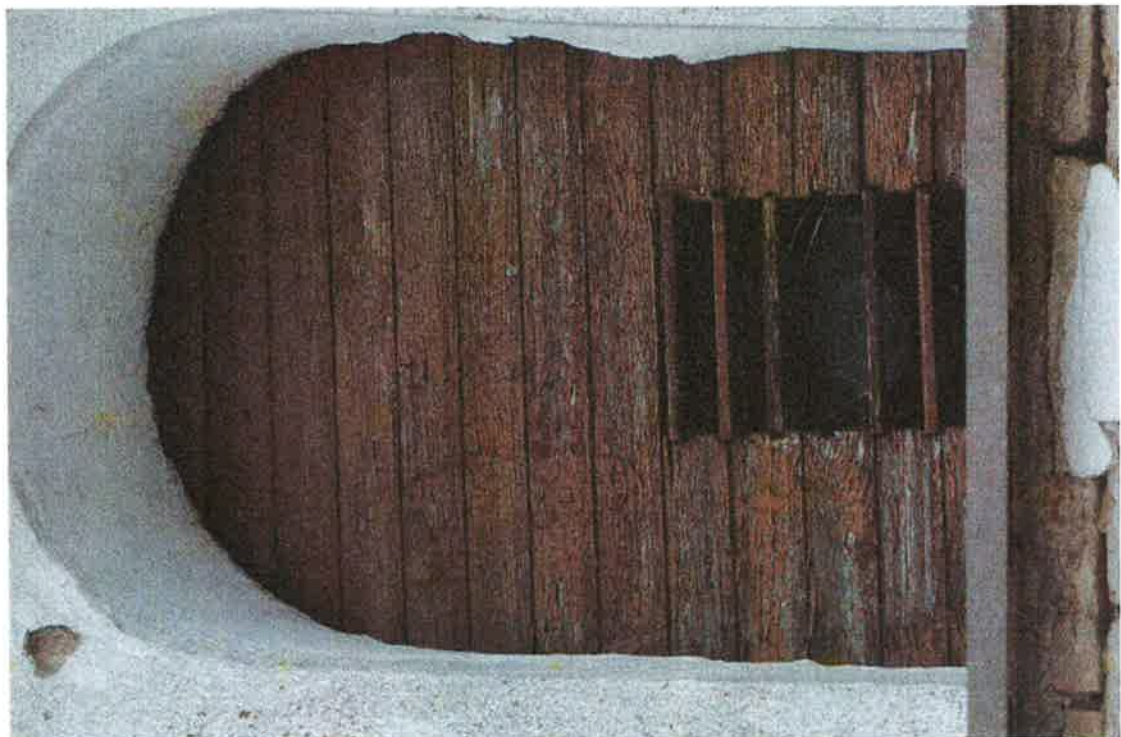
Il. 10 Chełmce, Kościół parafialny p.w. Św. Katarzyny – elewacja zachodnia wieży, III kondygnacja – widok na awers okiennicy deskowo-szpungowej opieranej dekoracją ramowo-deskową żaluzjową z żaluzją fot. Ewa Bożejewicz 2023 r.
