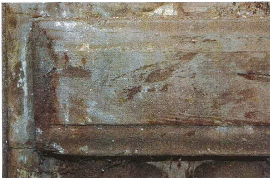
Il. 18 Chełmce, Kościół parafialny p.w. Św. Katarzyny Aleksandryjskiej, wieża - okiennice - widok na fragment szpungi konstrukcji deskowo-szpungowej okiennic
