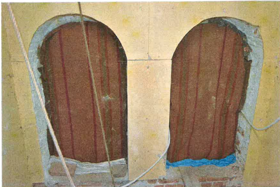
Il. 15 Chełmce, Kościół parafialny p.w. Św. Katarzyny – ściana zachodnia wieży, II kondygnacja - widok na otwory okienne, zamknięte okiennicami deskowo-szpungowymi, uszczelnione dywanami
