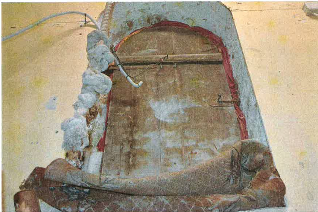
Il. 17 Chełmce, Kościół parafialny p.w. Św. Katarzyny – ściana północna wieży, II kondygnacja - widok na otwór okienny, zamknięty okiennicą deskowo-szpungową, uszczelnioną dywanem i materiałem fot. Ewa Bożejwicz 2023 r.
