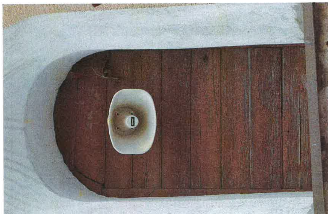
Il. 12 Chełmce, Kościół parafialny p.w. Św. Katarzyny – elewacja zachodnia wieży, II kondygnacja – widok na awers okiennicy deskowo-szpungowej opieranej dekoracją ramowo-deskową żaluzjową fot. Ewa Bożejewicz 2023 r.
