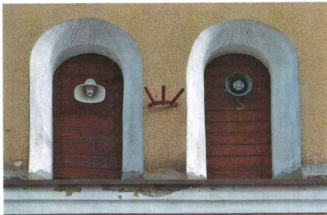
II. 8 Chełmce, Kościół parafialny p.w. Św. Katarzyny Aleksandryjskiej - elewacja zachodnia wieży – widok na okiennice w II kondygnacji
