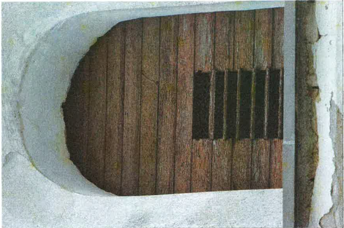
Il. 9 Chełmce, Kościół parafialny p.w. Św. Katarzyny – elewacja zachodnia wieży, III kondygnacja – widok na awers okiennicy deskowo-szpungowej opieranej dekoracją ramowo-deskową żaluzjową z żaluzją fot. Ewa Bożejewicz 2023 r.
