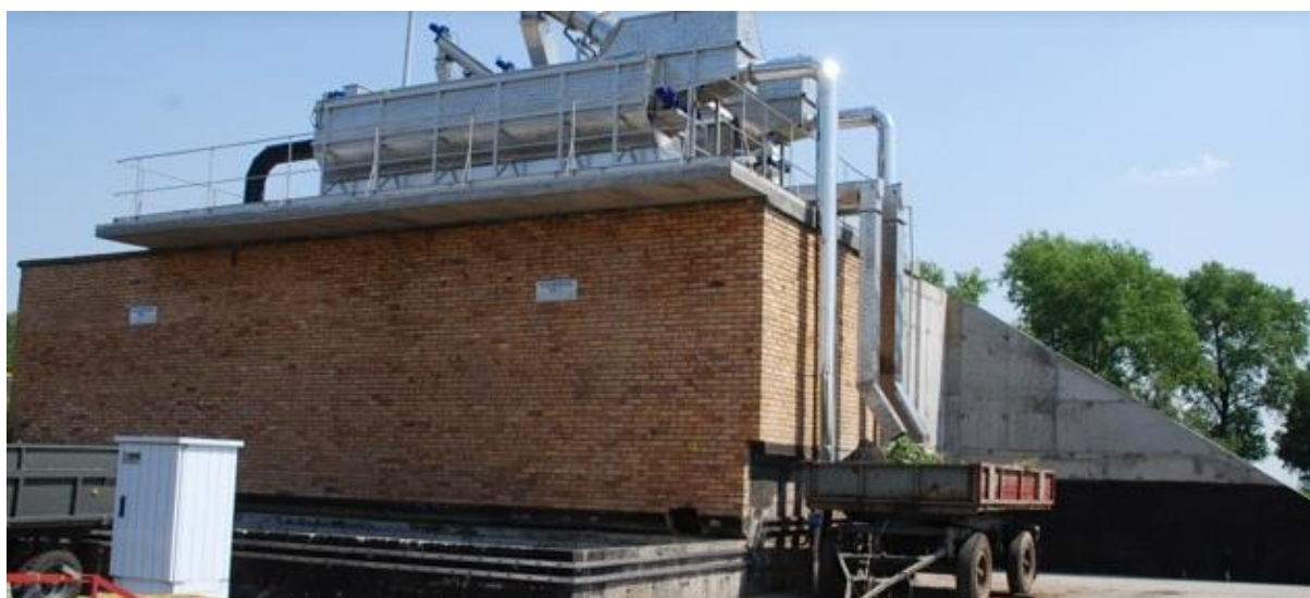
Fot. 15 Oczyszczalnia ścieków w Kruszwicy
