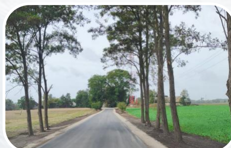
przebudowana droga w Arturowie
