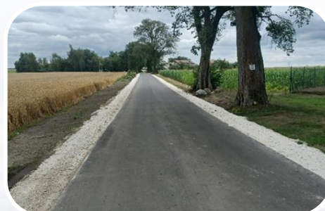
droga w Sukowach po przebudowie
