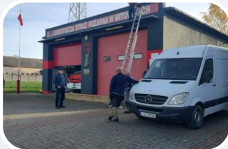
remont dachu w Witowicach
