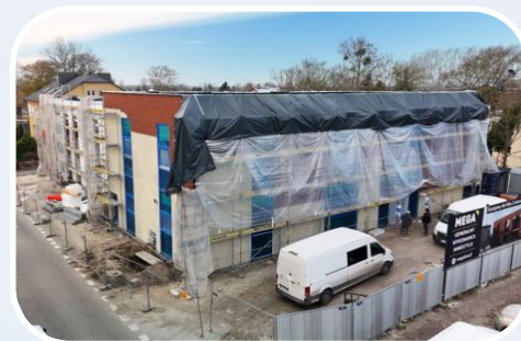
CKiS "Ziemowit" w trakcie rozbudowy
