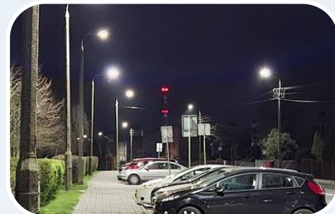
nowe oświetlenie drogowe
