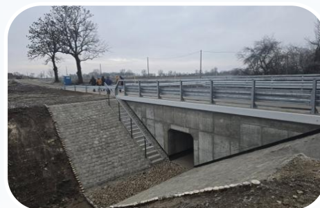
Nowy przepust w Janowicach
