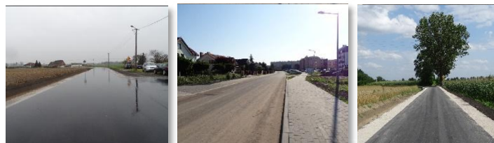
Droga gminna w Przedbojewicach po przebudowie
