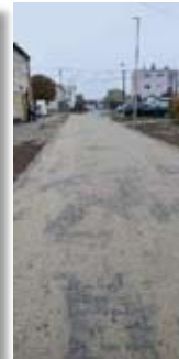
Droga w Polanowicach po przebudowie
