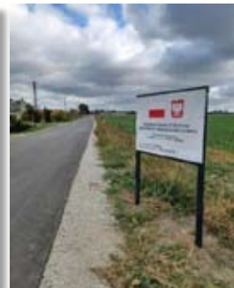
Droga gminna w Baranowie po przebudowie
