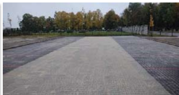
Nowy parking przy cmentarzu komunalnym w Kruszwicy
