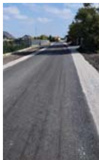
Ulica Wrzosowa w Kruszwicy po przebudowie
