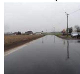
droga gminna w Przedbojewicach po przebudowie
