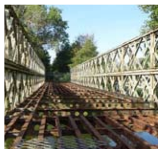
most w Kobylnikach przed przebudową
