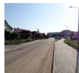
przebudowana ul. Wspólna
