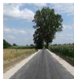
przebudowana droga gminna w Witowiczkach
