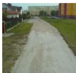
ul. Wspólna przed przebudową
