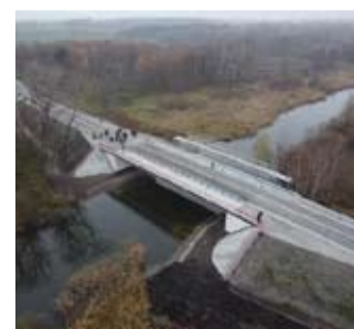
most w Kobylnikach po przebudowie
